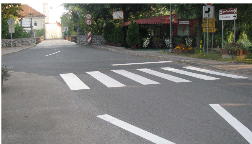
Fotografija št. 4: Prehod za pešce v križišču Ljubljanske in Gorjanske ceste
